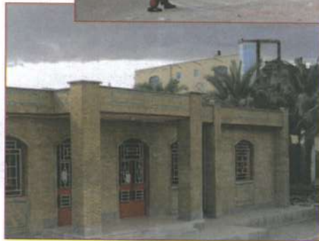
۷- مهاربندی دیوار جان‌پناه بوسیله مهار عمودی در سقف و ضربدردی از نوع میلگرد در حداثفصل شناژهای عمودی ضروری است.
