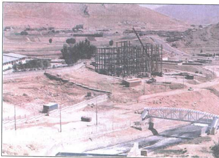
مجتمع در حال ساخت در حریم بلافاصل کانال
